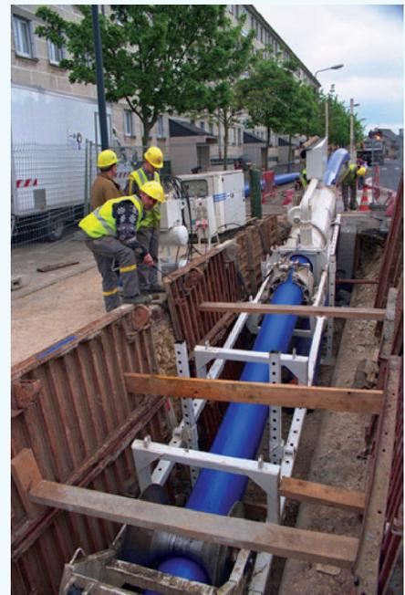
Renouvellement sans tranchée d'une canalisation d'eau potable
